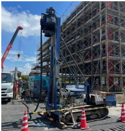
③さく井機械（エアハンマー工法）
