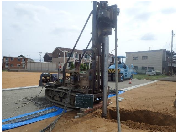
④さく井機械（エアハンマー工法）
