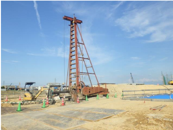
①さく井機械（パーカッション工法）
