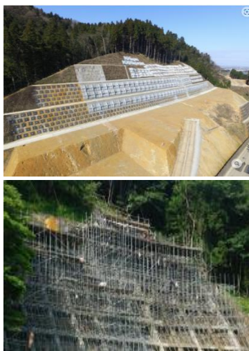
グラウンドアンカー工
