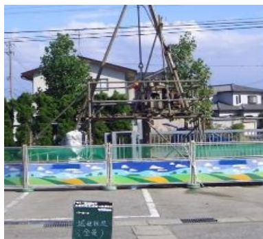
ボーリング作業 全景
